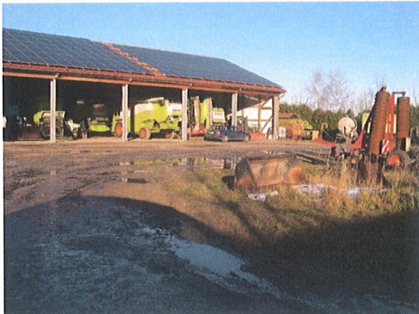
Abb. 8 Bestehende Halle mit PV-Anlage und Verkehrsflächen
